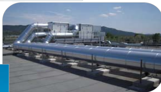
AREVA-COMURHEX Centrale de Traitement de l'Air à Pierrelatte (26)
